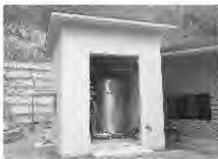
▲市野川浄水場臭気除去棟
